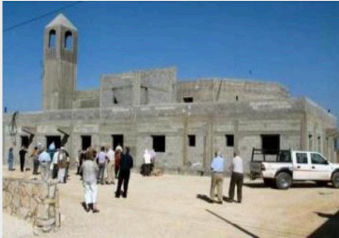
Construção de igrejas
